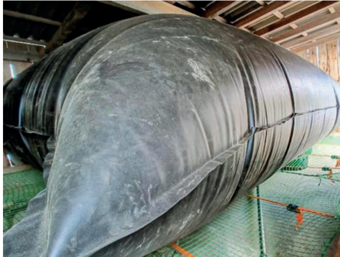
Gasballon unter Dach
