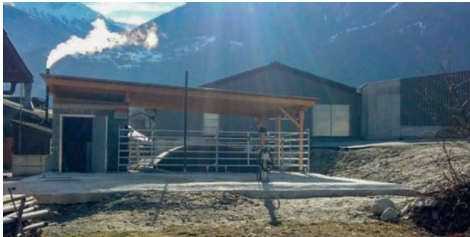
Anlage unter Terrain, Peter, Wallis/Schweiz
